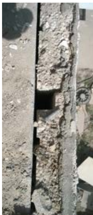
Slika 1: Nedovoljan i neodgovarajući nanos morta za lijepljenje.
