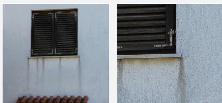
Slika 10 i 11: Nepravilna izvedba klupčice
