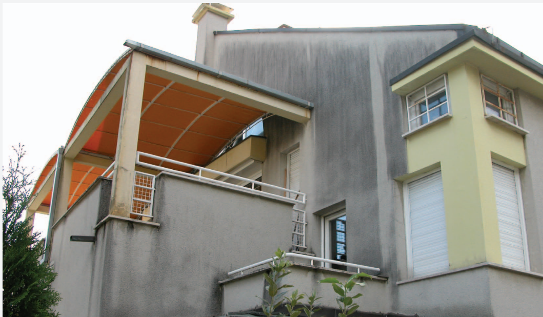
Slika 5: Gljivice na fasadama
